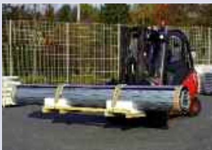
Kompakt verpackt kann der Rollpanzer mit Hilfe eines Gabelstaplers auf die vormontierte Konsole gesetzt werden.
